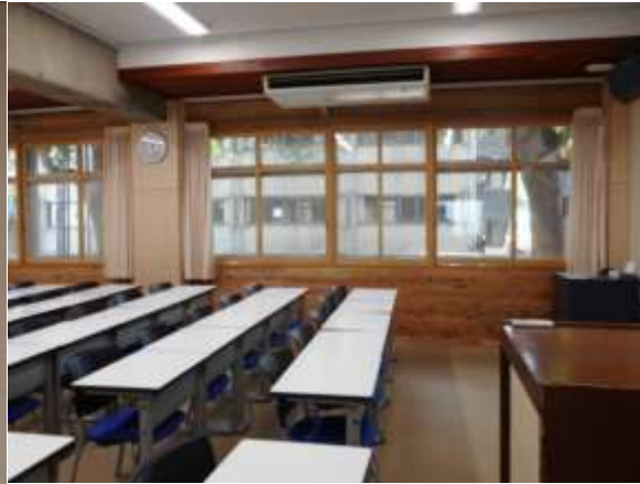
二重窓と断熱材を貼り付けた壁
