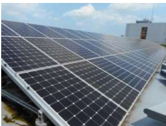
1 号館屋上の太陽光パネル
